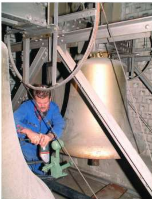
Montage des Angelusschlages
