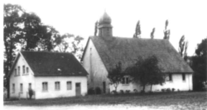
Die 1956 fertiggestellte St. Elisabeth-Kirche in Altenhagen; daneben Hausmeisterwohnung des Heimes, später umgebaut zum Pfarrheim.
