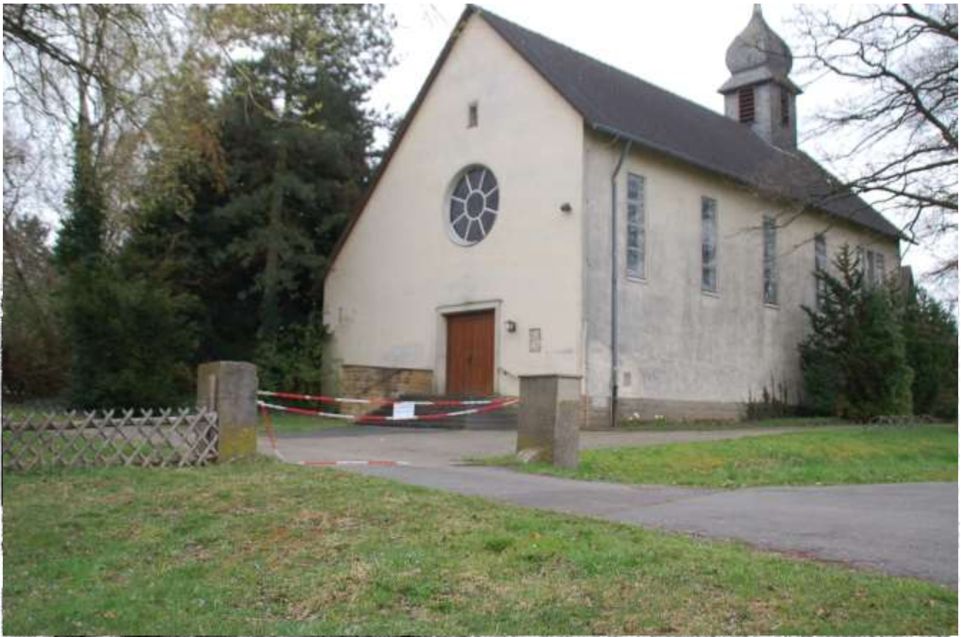
Kleines Einzugsgebiet: Die Elisabeth-Kirche in Altenhagen am Vogelbach liegt an der nordwestlichen Stadtgrenze. Sie wurde immer weniger genutzt und steht nun zum Verkauf. Dazu gehört auch das Gemeindehaus hinter dem Gotteshaus. FOTO: ANDREAS ZOBIR
